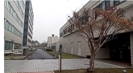
④CMS玄関前 (道幅5m)
